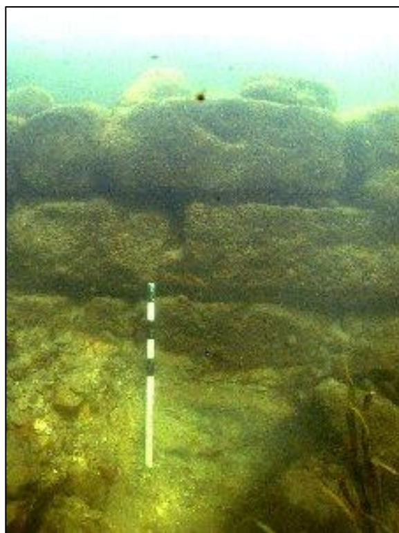
Fig. 21 : Substructions en gros appareil sous le pont du Maréchal Leclerc à Melun. © P. Bonin, GRAS.
