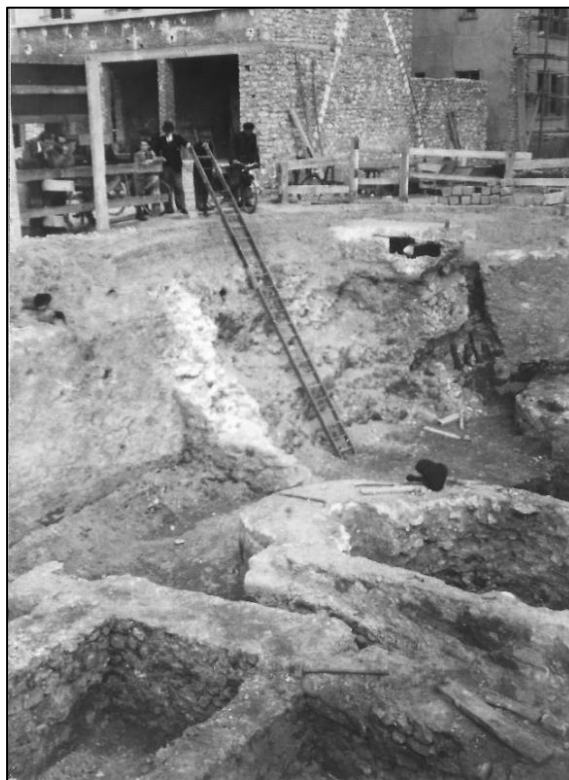
Fig. 16 : Détail de la substruction occidentale mise au jour en 1948. © Lasseron, ADSM 77.
