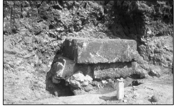
Fig. 4 : Élément du soubassement du rempart du castrum au sud de l'île. © J.-C. Chanez, 1971.
