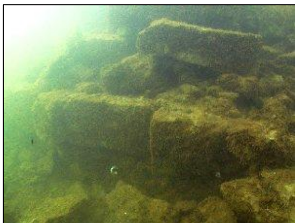
Fig. 20 : Substructions en gros appareil sous le pont du Maréchal Leclerc à Melun. © P. Bonin, GRAS.
