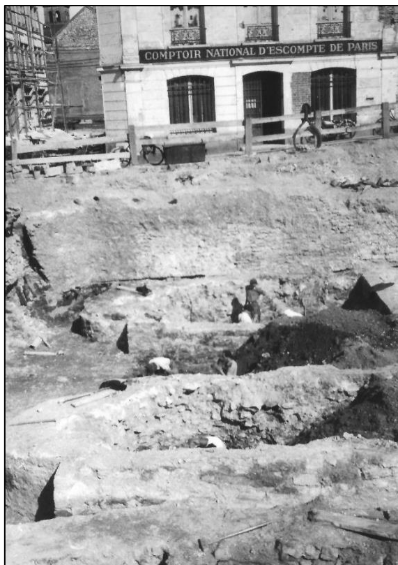
Fig. 15 : Vue générale des substructions mises au jour en 1948. © Lasseron, ADSM 77.
